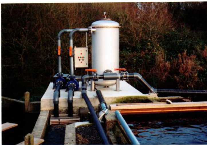
Réacteur sous pression Aquavi ou bicône
